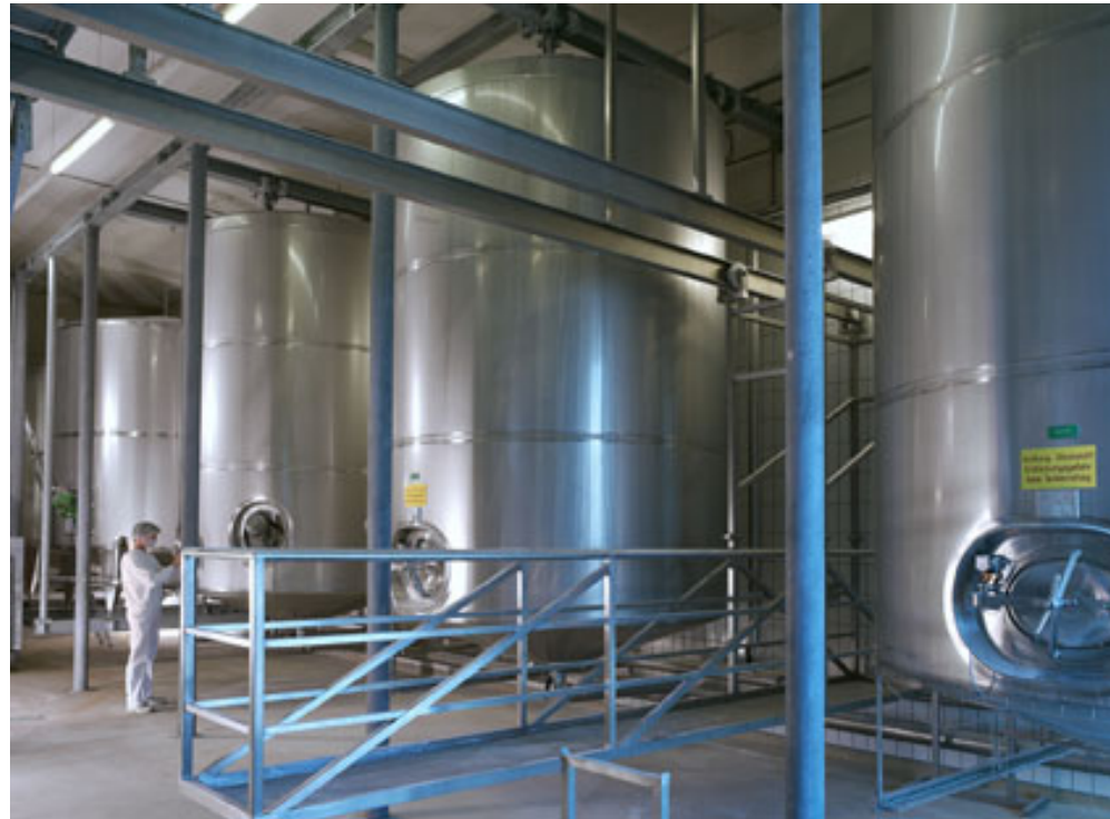
Blick auf die neu geplante Anlage, eingehängt im neuen Stahlbau.
