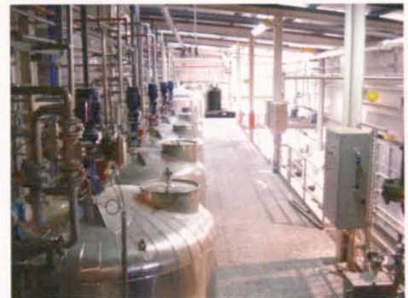
... bis zum Aufbau der gesamten Anlage vor Ort.
