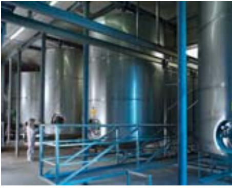
Aus statischen und hygienischen Gründen konnten die Tanks nicht einfach auf den Boden gestellt werden
