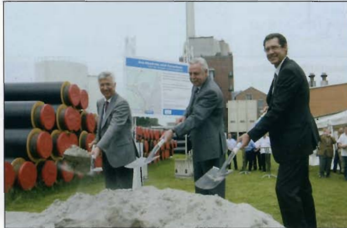
Oberbürgermeister Heinz Fenrich (Mitte), MiRO-Geschäftsführer Dr. Hans-Gerd Löhr (rechts) und Dr. Karl Roth, technischer Stadtwerke-Geschäftsführer, beim symbolischen Spatenstich für das Großprojekt beim Heizkraftwerk West
